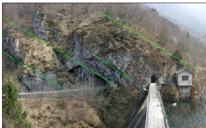
Fig.1: sponda dx, andamento della St in bancate massicce di spessore plurimetrico.
