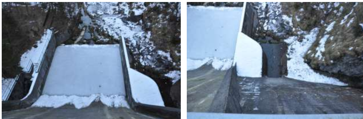
Diga stato di fatto – A sx Vasca di dissipazione, a dx Canale dello scarico di fondo
