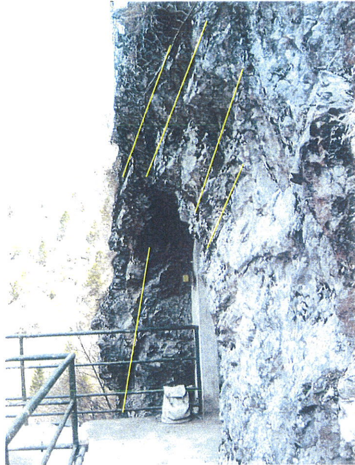
Foto 3: Diga di Cassiglio, sponda dx: discontinuità del sistema K2.
