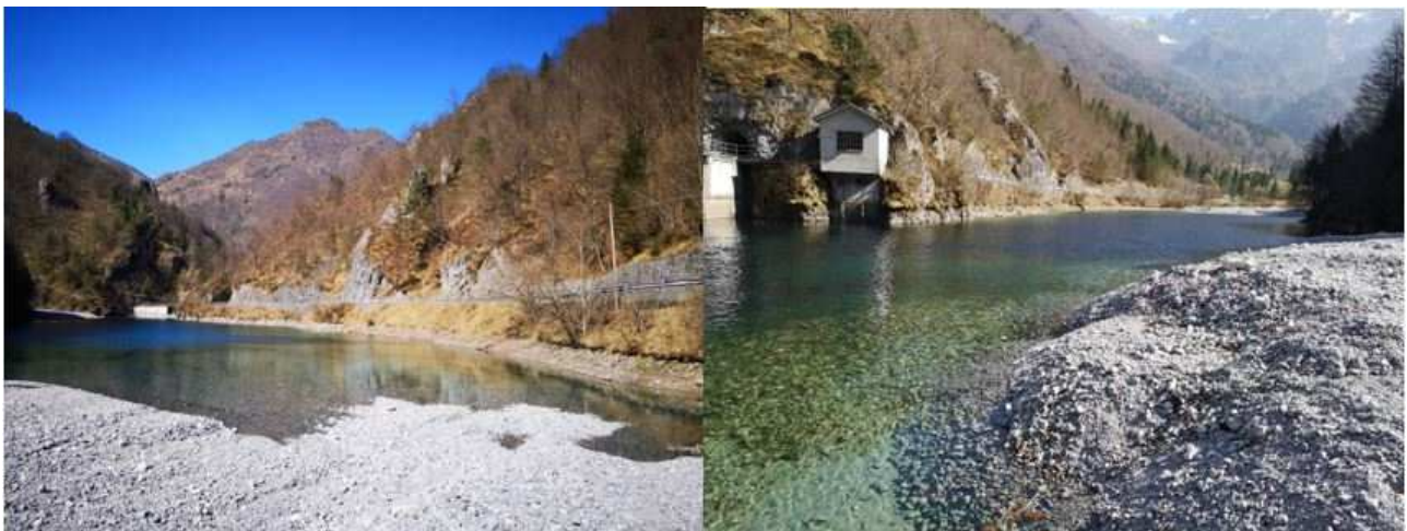
Fig. 18: Nella foto riportate si evidenzia la situazione degli accumuli di depositi presenti al bacino di Cassiglio e alimentati dalla valle di Cassiglio (foto a sinistra) e dalla Valle dei Faggi (foto a destra).
