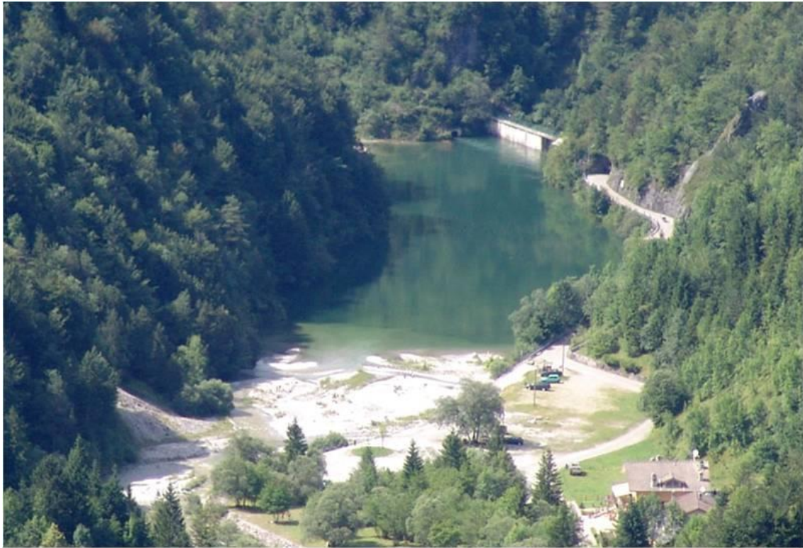
Figura 10 – Contesto ambientale con vista dell'invaso dall'alto, da monte verso valle
