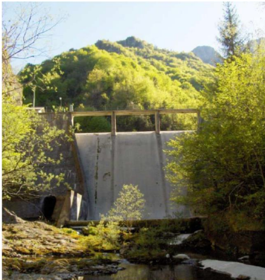
Figura 13 – Contesto ambientale – Tratto a valle dello sbarramento
