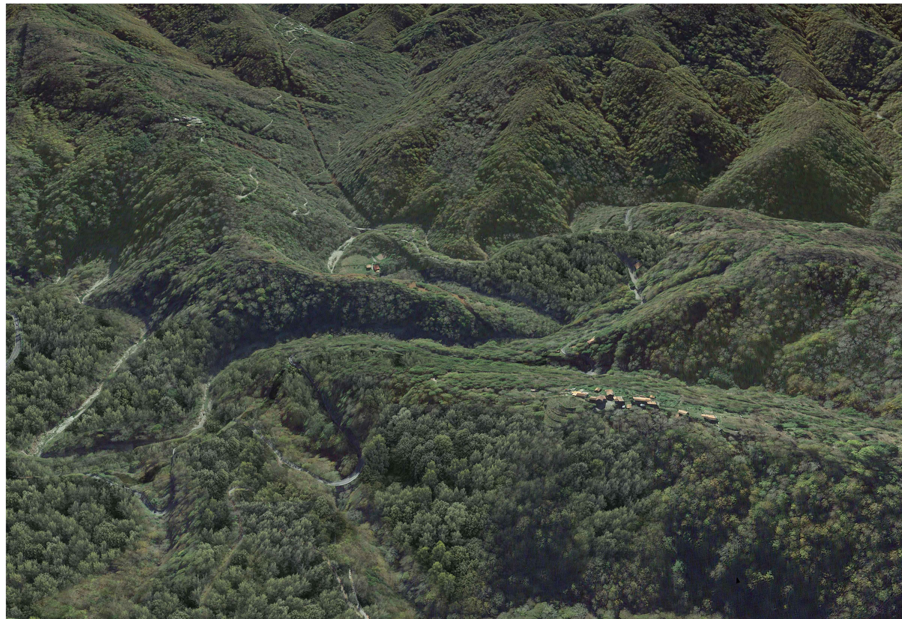
03 - ANTE OPERAM - Vista a volo d'uccello da SO verso NE
