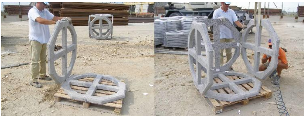
Fase di montaggio
