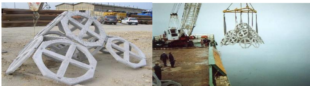
Sollevamento dei moduli
