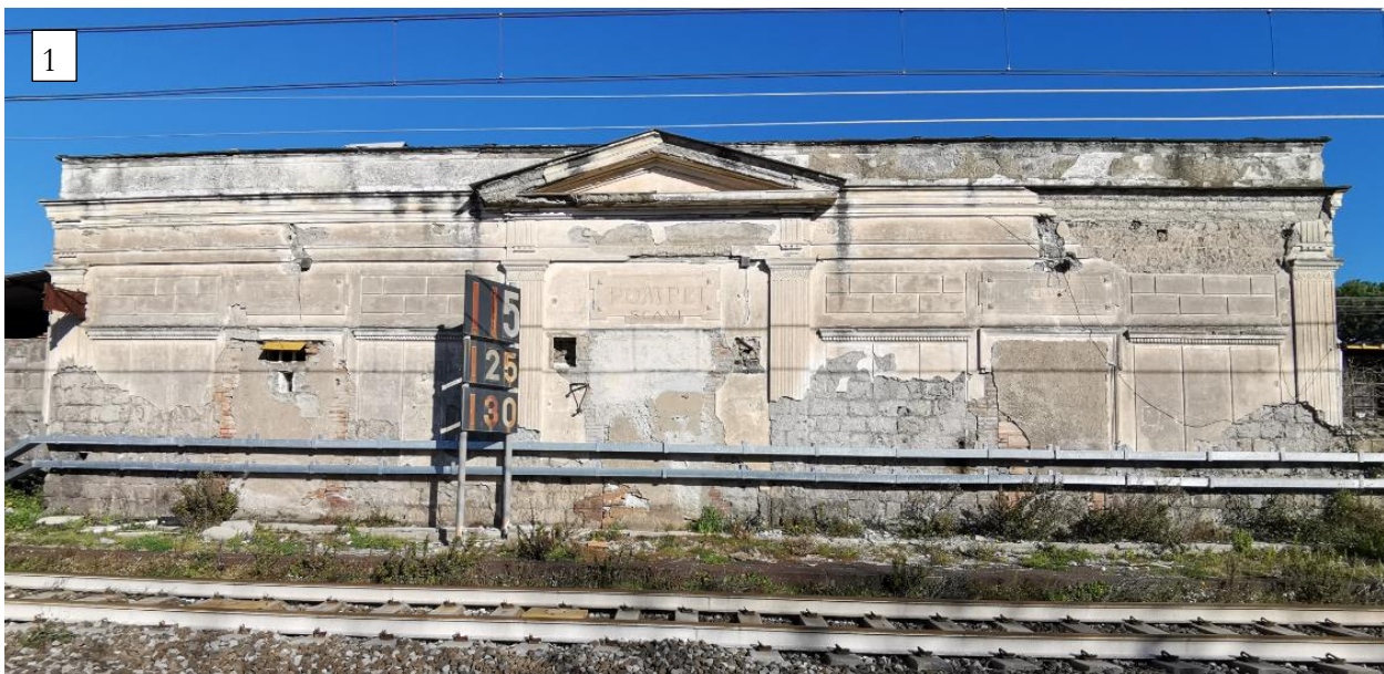
Figura 15: Stato di fatto fabbricati dell'antica Fermata Pompei Scavi – prospetto lato binari
