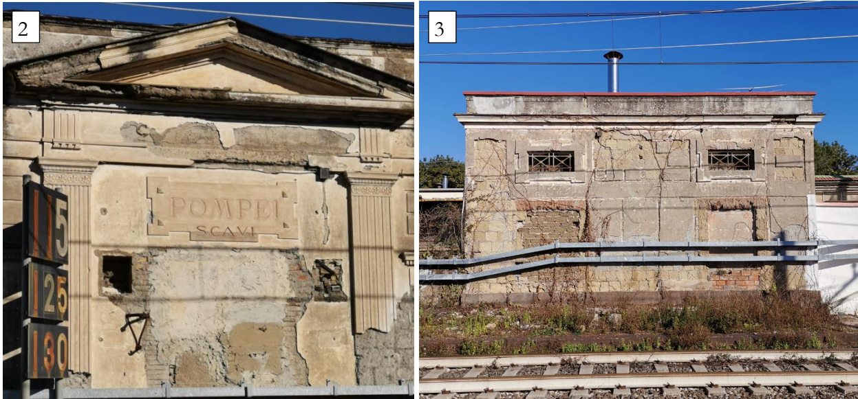
Figura 16: Stato di fatto fabbricati dell'antica Fermata Pompei Scavi – dettaglio del timpano del Fabbricato viaggiatori e del prospetto lato binari del locale bagni
