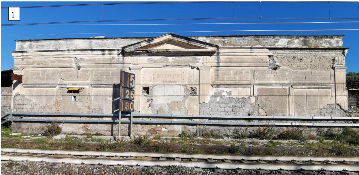
Figura 9: Stato di fatto fabbricati dell'antica Fermata Pompei Scavi – prospetto lato binari
