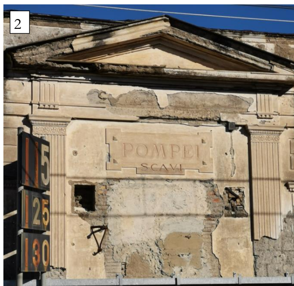
Figura 10: Stato di fatto fabbricati dell'antica Fermata Pompei Scavi – dettaglio del timpano del Fabbricato viaggiatori e del prospetto lato binari del locale bagni
