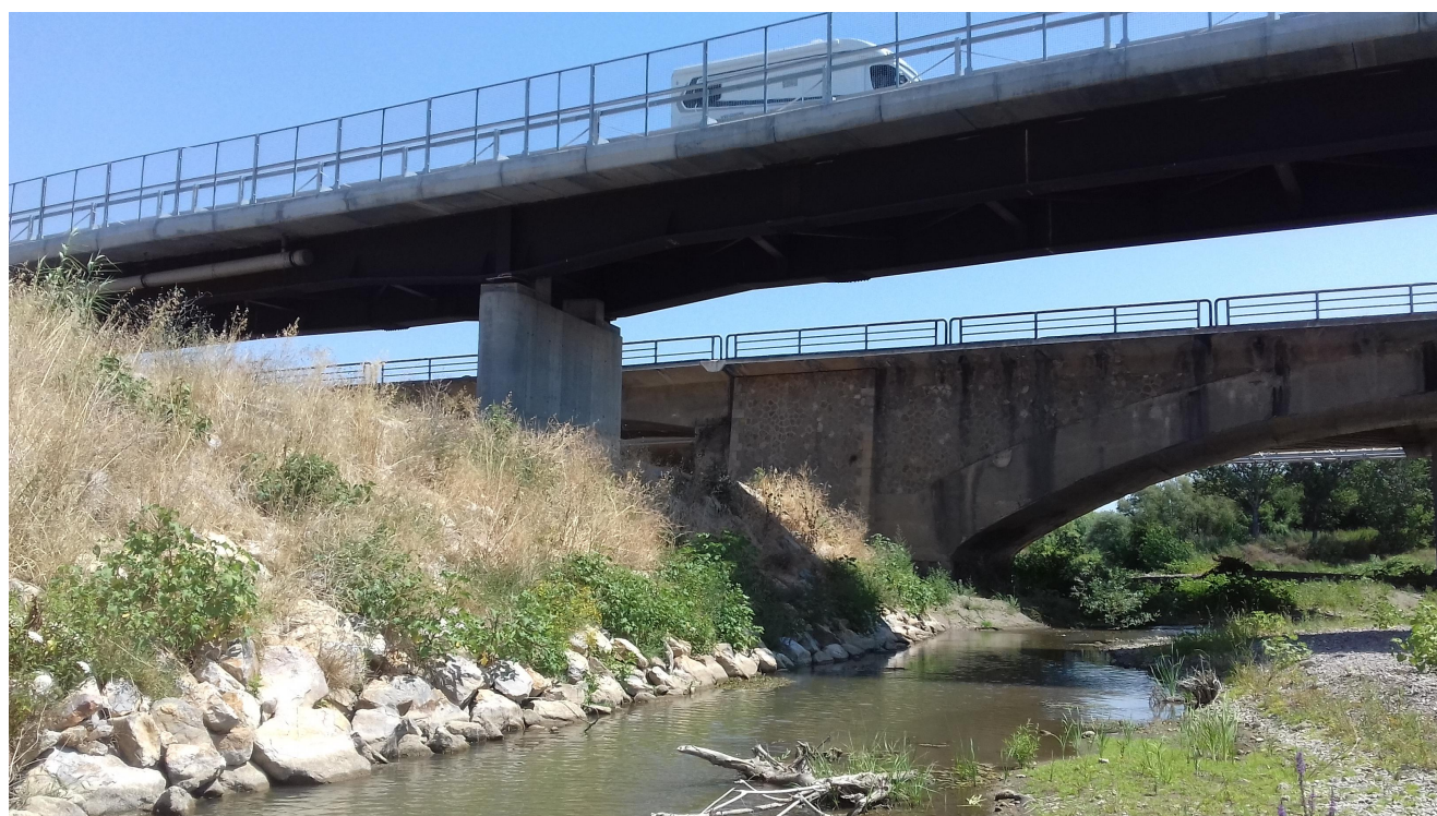
Foto 2– Nuova viabilità, attraversamento Fiume Mignone
