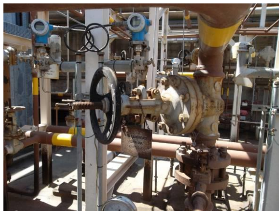
Figura 4: Particolare Valvola di mandata pompa
