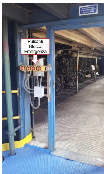
Figura 6: Pulsanti arresto emergenza singolo bruciatore
