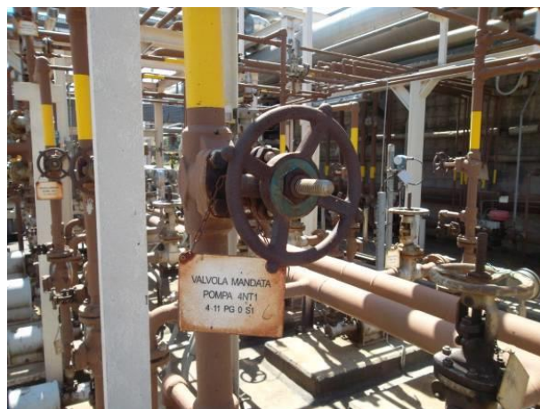
Figura 2 - Valvola tubazione mandata gasolio torce caldaia
