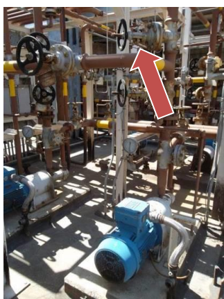
Figura 3: Valvole pompe gasolio avviamento caldaia
