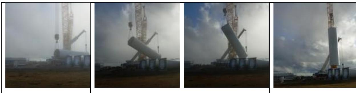
Figura 5.11 – Schema delle fasi di sollevamento dei componenti dell’aerogeneratore (Fonte sito web <http://www.windfarmbop.com/>)
