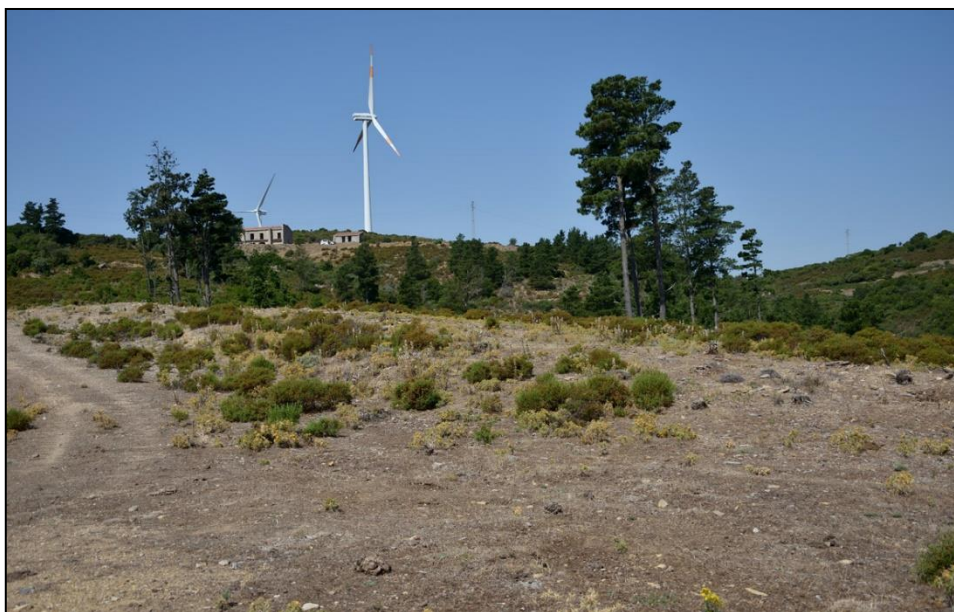
Figura 34– Stato attuale dell'area della piazzola dell'aerogeneratore J09.
