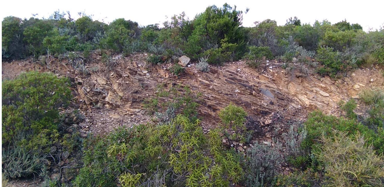
Foto 11 - particolare di un taglio stradale con i suoli che non raggiungono i 10/20 cm di profondità
