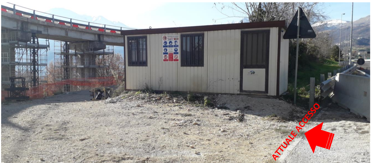
Figura 29 - Stato attuale della zona destinata ad area Cantiere Sud
