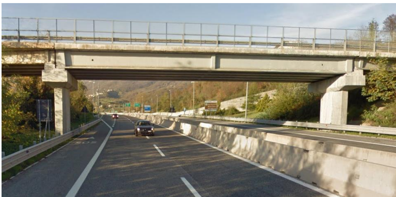
Figura 2: Panoramica e vista dall'autostrada del cavalcavia allo stato di fatto
