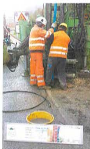
S1 - POSA PIEZOMETRO
