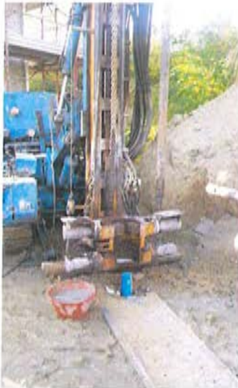
S3 - POSA PIEZOMETRO
