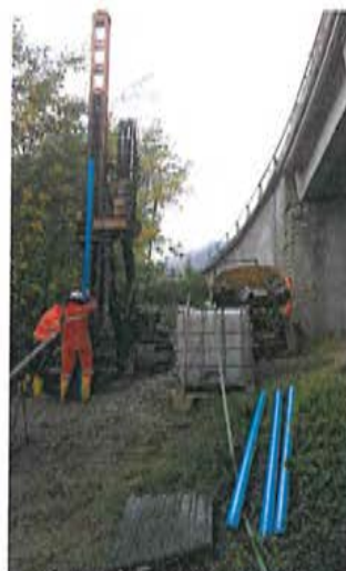
S4 - POSA PIEZOMETRO
