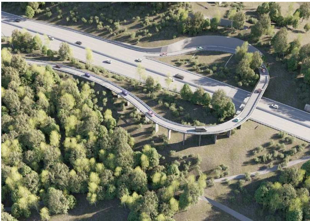
Figura 7.58 - Vista sud-est dello Svincolo San Gabriele stato di fatto
