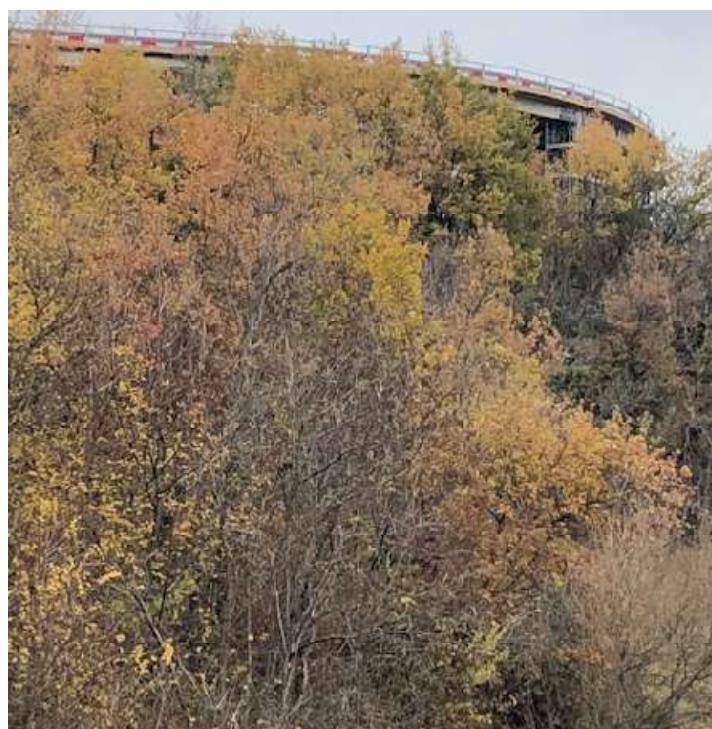
Figura 7.50 e 7.51 - Un tratto dello svincolo visibile dalla strada poderale a sud
