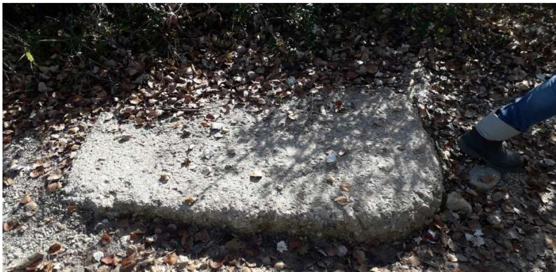
Figura 6.30 Immagine del pozzetto esistente
