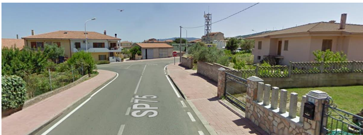
Figura 18 – Vista dell'incrocio all'interno dell'abitato di Erula tra la SP 75 e la SP 2 che richiede una temporanea modifica del muretto di recinzione del giardino di un'abitazione privata, che sarà ripristinato alla fine del trasporto delle pale eoliche.
