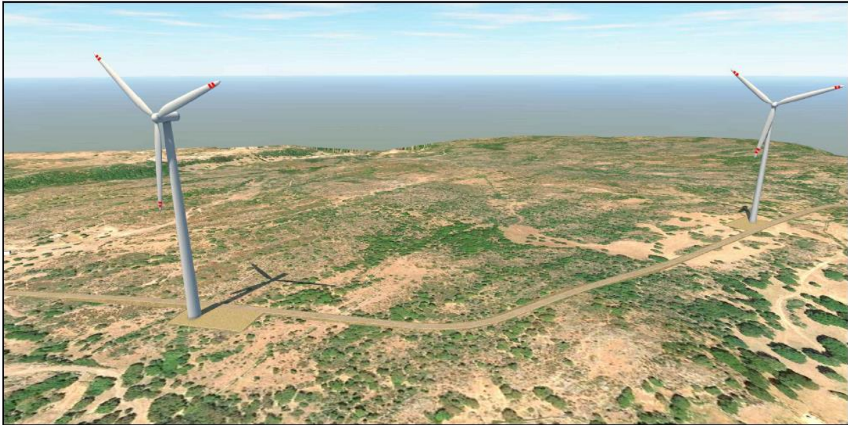
Figura 25 – Vista del modello render 3D con la viabilità di cantiere e di esercizio presso la WTG OZ4 e OZ5.
