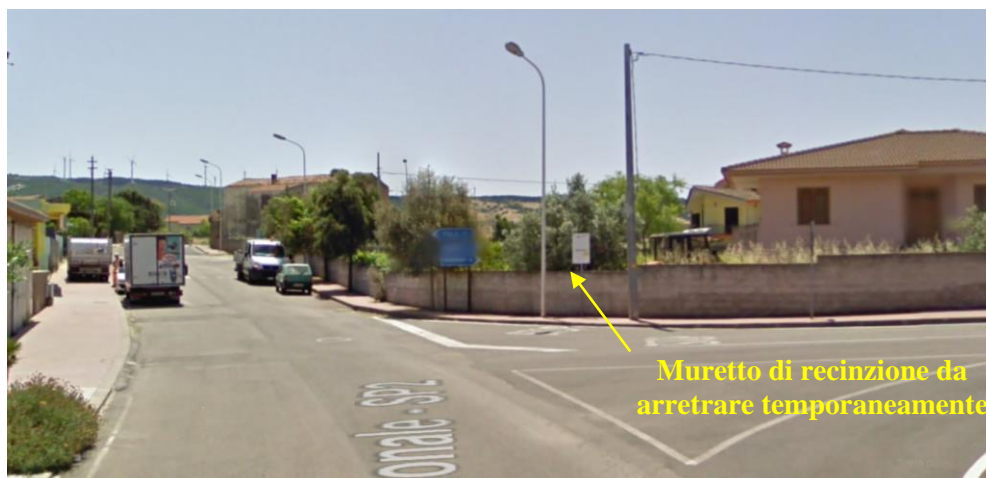
Figura 19 – Vista dell’incrocio all’interno dell’abitato di Erula tra la SP 75 e la SP 2 che richiede una temporanea modifica del muretto di recinzione del giardino di un’abitazione privata, che sarà ripristinato alla fine del trasporto delle pale eoliche.
