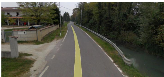
Figura 6 – Stato di fatto su via Caiselli ad est della ferrovia
