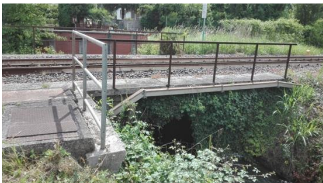
Figura 5 – Stato di fatto attraversamento ferroviario Roggia di Palma
