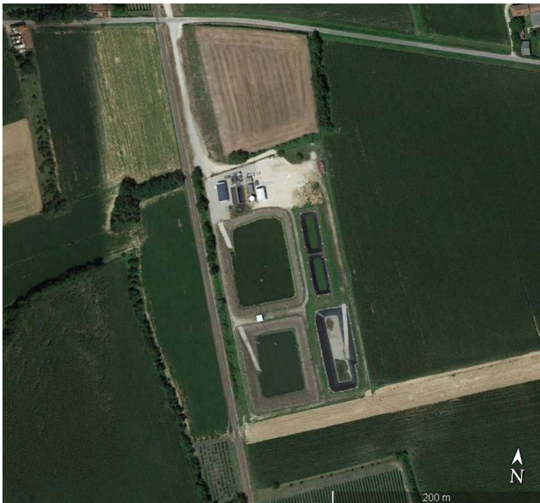
Figura 4-1 – Impianto di depurazione e vasche in località Cortello.
