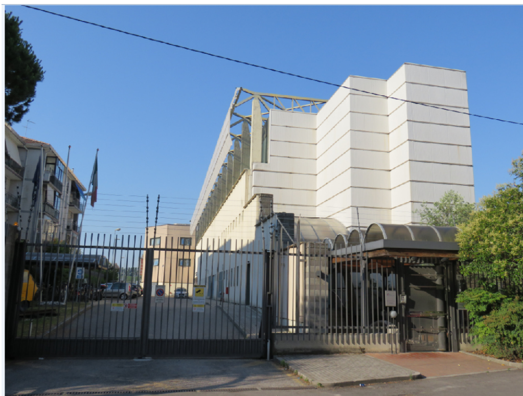
Figura 10 – Palazzo SCC di Venezia Mestre
