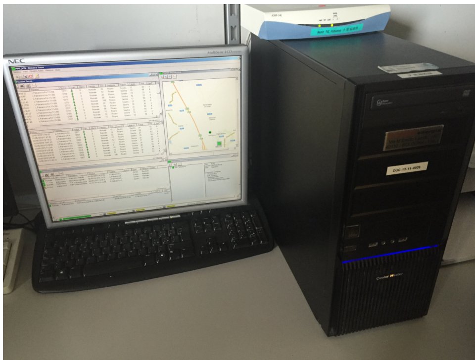
Figura 15 – Posto Centrale RTB con postazione ubicato nell’U.M. di Palmanova
