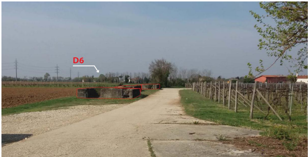
Figura 18 - – Vista dalla strada poderale dei tre manufatti ad uso agricolo da demolire a Est – Sud-Est di Risano
