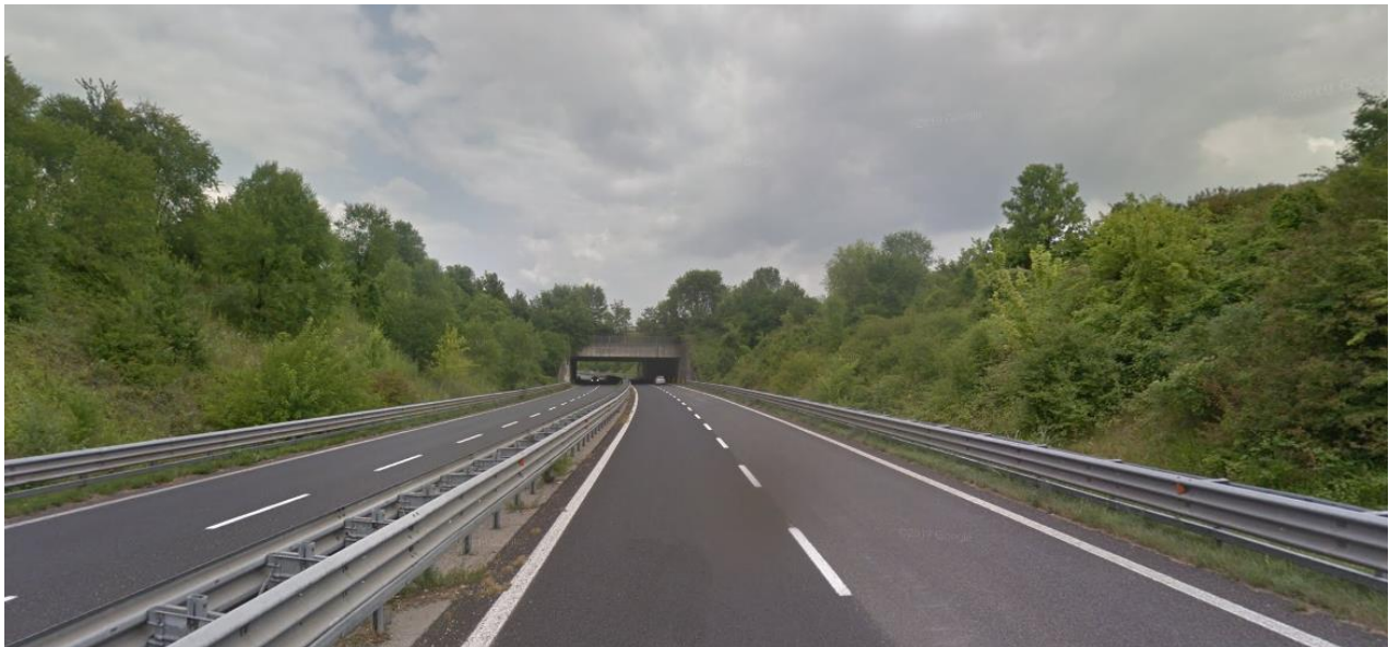
Figura 67 - Tratto della SR 56 in prossimità del sottopasso ferroviario
