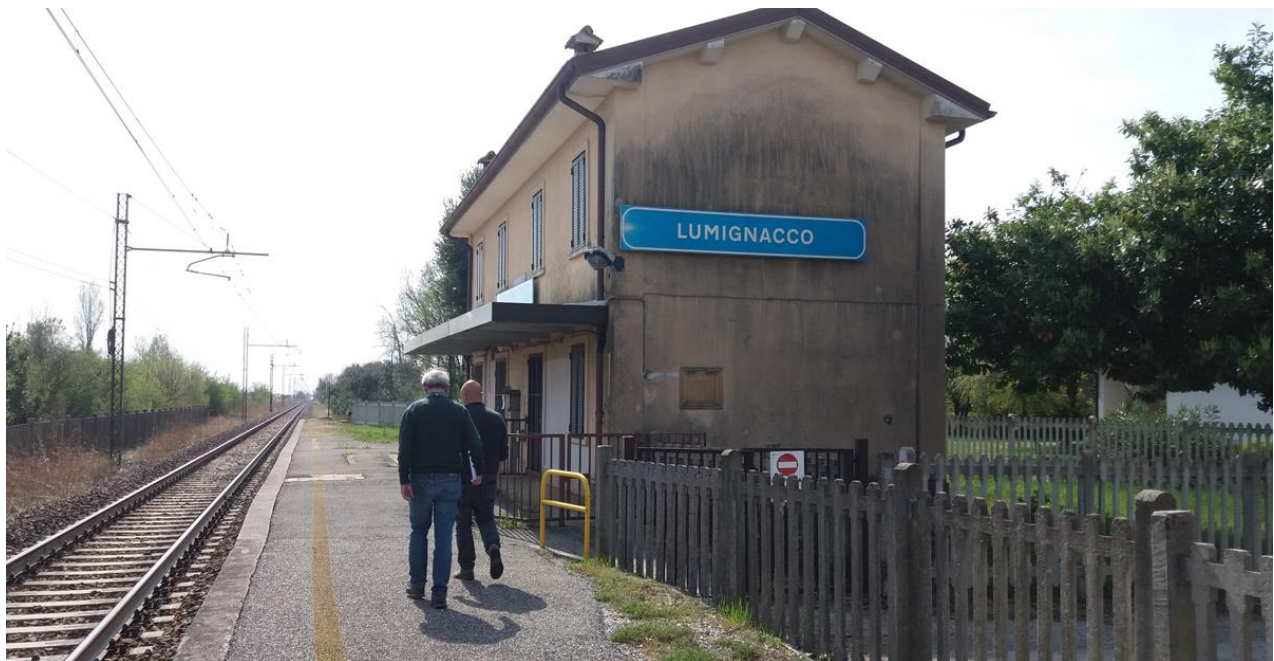
Figura 15 - Fabbricato viaggiatori stazione di Lumignacco (D3)
