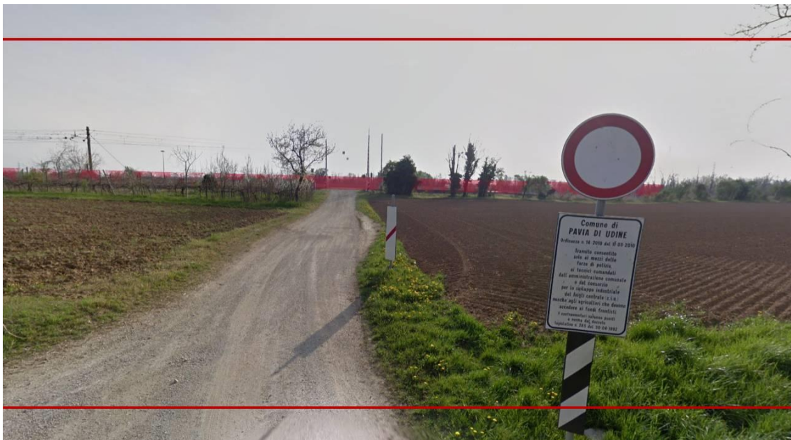
Figura 86 via dei Capiltelli, Lumignacco - barriera antirumore H0
