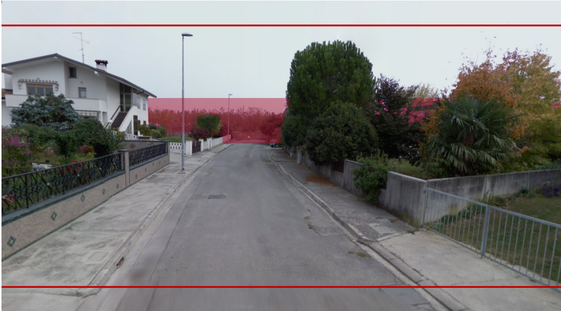
FIGURA 61 VIA G. GALILEI, LUMIGNACCO - BARRIERA ANTIRUMORE H10
