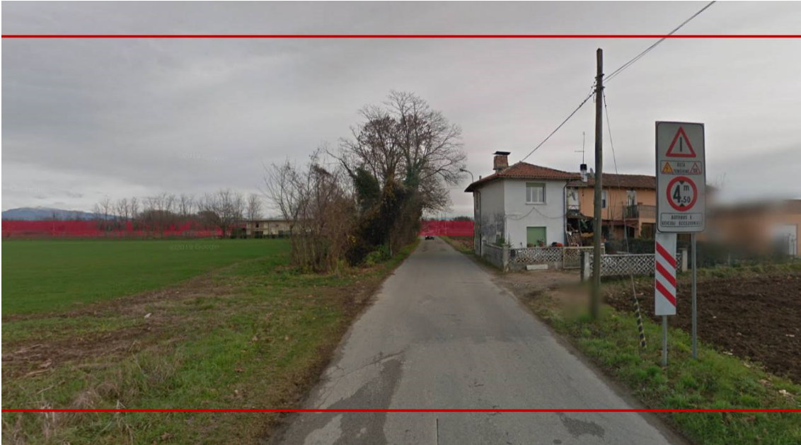
FIGURA 59 VIA CORTELLO LUMIGNACCO - BARRIERA ANTIRUMORE H2
