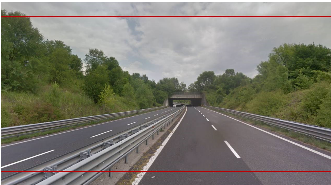
FIGURA 38 TRATTO DELLA SR 56 IN PROSSIMITÀ DEL SOTTOPASSO FERROVIARIO
