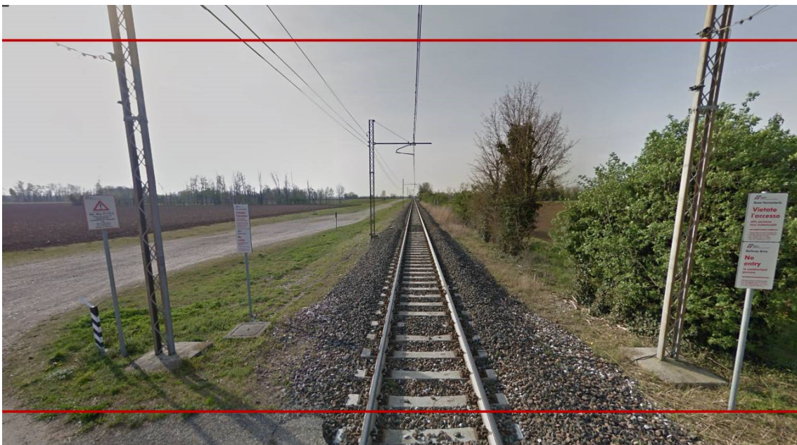
FIGURA 39 E FIGURA 40 E TRATTO DELLA LINEA UDINE PALMANOVA, PASSAGGIO A LIVELLO VIA DEI CAPITELLI, LUMIGNACCO
