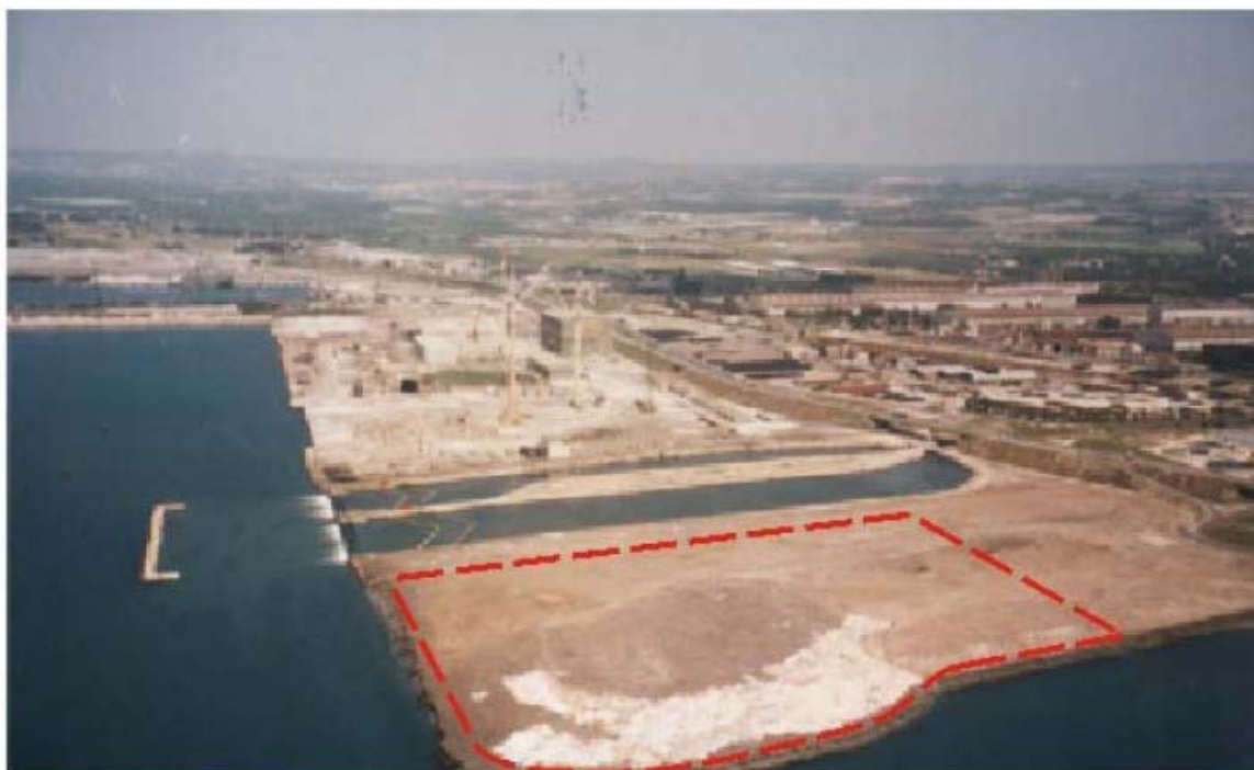
Fig.1.7 - Visione dell'area da cui emerge la carenza di naturalità.
