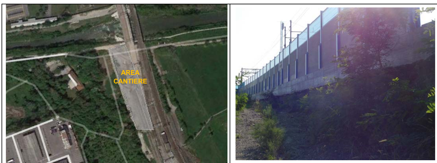
Figura 4-6 Localizzazione dell'area di cantiere posta a monte della linea ferroviaria (a sinistra); veduta della linea ferroviaria a valle (a destra).
