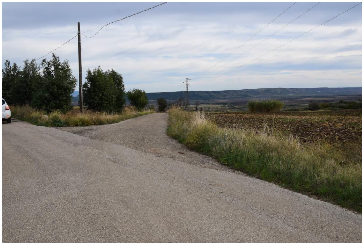
Figura 15: Incrocio tra strada comunale “San Leucio” e strada vicinale “San Paolo” che necessita di allargamento.
