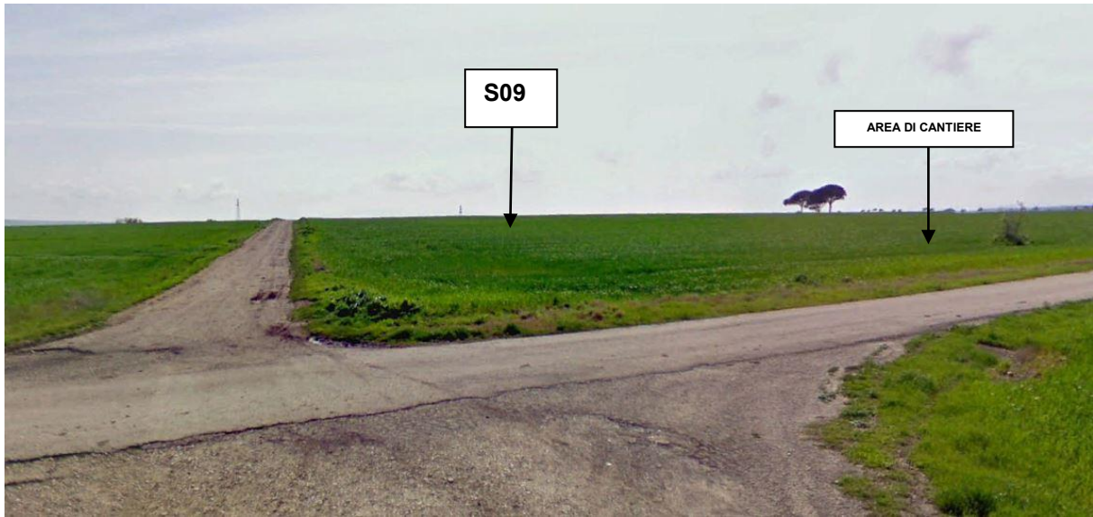
Figura 9 – Vista dell’area d’impianto in prossimità dell’aerogeneratore S09 accessibile da strada comunale “Maddalena-Ischia”. Sulla destra dell’aerogeneratore è prevista la realizzazione di un’area di cantiere temporanea.
