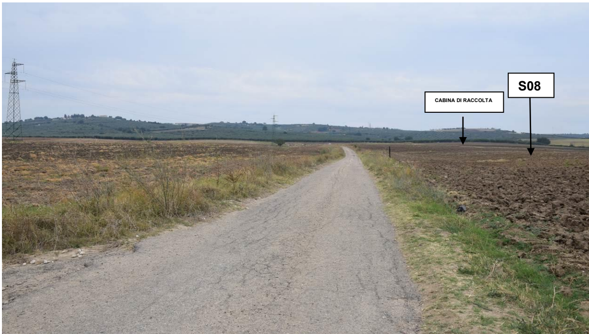
Figura 8 – Vista dell’area d’impianto in prossimità dell’aerogeneratore S08 accessibile da strada comunale “Maddalena-Ischia”. Sulla destra dell’aerogeneratore S08 è prevista la realizzazione della cabina di raccolta.
