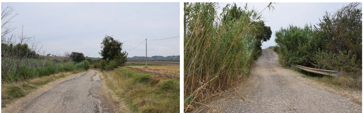
Figura 3 – Attraversamento del cavidotto sul Canale Maddalena (reticolo di connessione della RER) lungo strada comunale Maddalena Ischia. Il cavidotto attraversa il canale lungo la strada asfaltata esistente. Il canale è superato con TOC.
