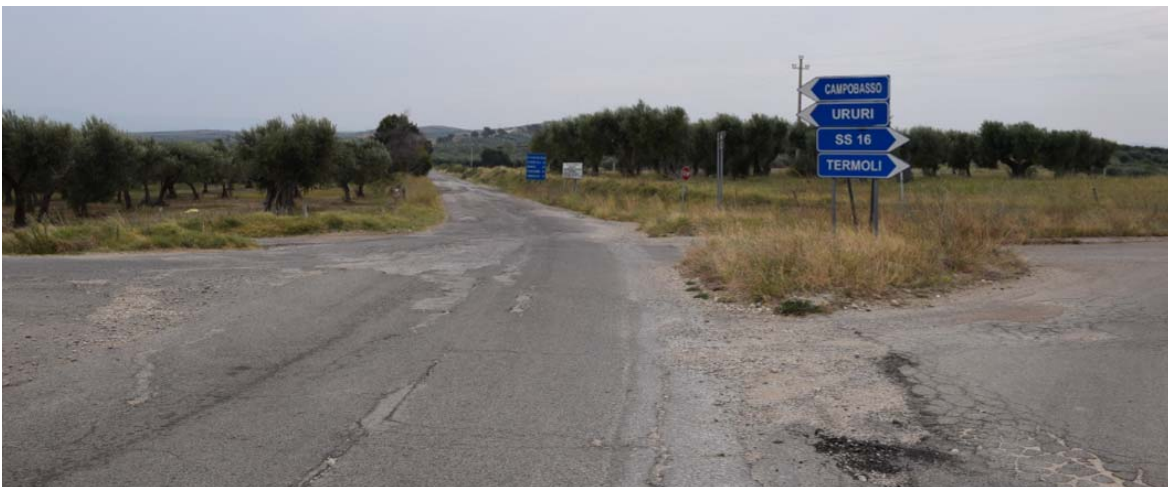
Figura 9 – Strada Statale n. 16_ter e imbocco della Strada Statale n. 376. Lo svincolo sarà superato per il tramite di TOC. Il tratto è interessato dal Regio Tratturo L'Aquila Foggia
