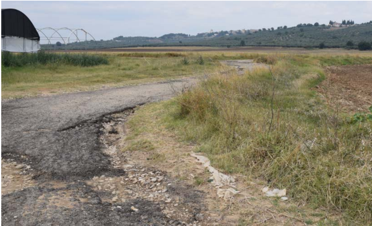
Figura 7 – Strada comunale Maddalena Ischia lungo la quale sarà posato il cavidotto esterno. La foto rappresenta il tratto di strada interessato dall’area di Rispetto del Sito Storico Culturale riferito al rudere Mass. Maddalena.
