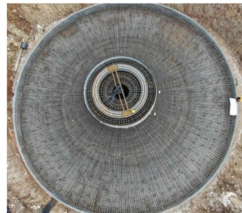
**Figura 1.1 in alto e al centro e in basso, viste dell'area di impianto a est di Serracapriola; in basso, vista dall'alto dell'armatura del plinto di fondazione di un aerogeneratore in fase di esecuzione e montaggio.**
