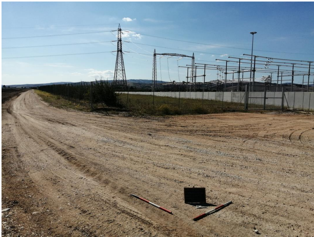
Area della Stazione elettrica e grado di visibilità delle superfici
