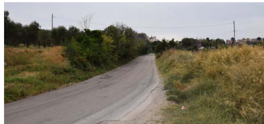
Figura 12 –SS 16_ter. La strada è interessata dalla posa del cavidotto esterno. Il tratto in foto è interessato dall’Area di rispetto della Rete Tratturi
