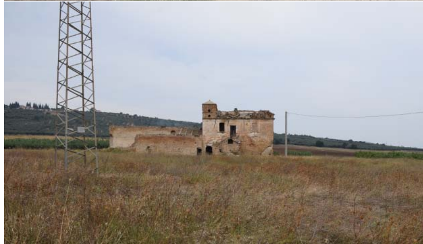
Figura 9 – Strada comunale Maddalena Ischia. Il tratto in foto interseca il sito interessato dal Bene Storico Culturale – Mass. La Loggia – e relativa area di rispetto. Si nota lo stato di completo abbandono della masseria.
