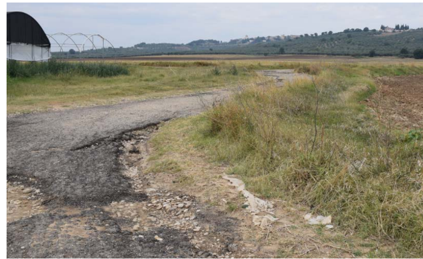
Figura 11 –Strada comunale Maddalena Ischia lungo la quale sarà posato il cavidotto esterno. La foto rappresenta il tratto di strada interessato dall'area di Rispetto del Sito Storico Culturale riferito al rudere Mass. Maddalena.
