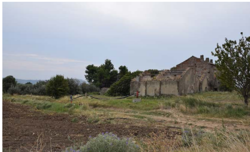
Figura 10 – Masseria Maddalena. Si nota lo stato di completo abbandono della masseria indicata sul PPTR come UCP Sito interessato da Bene Storico Culturale. Il cavidotto esterno non interessa tale UCP ma è posato lungo la strada asfaltata in pessimo stato che interseca il suo buffer UCP Area di Rispetto del Sito Storico Culturale (foto successiva).
