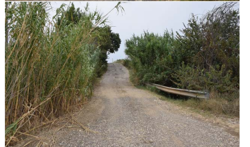
Figura 7 – Attraversamento del cavidotto sul Canale Maddalena (reticolo di connessione della RER) lungo strada comunale Maddalena Ischia. Il cavidotto attraversa il canale lungo la strada asfaltata esistente. Il canale è superato con TOC.
