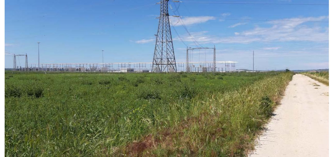
Figura 17 – Stazione RTN 380 kV “Rotello” di proprietà Terna
