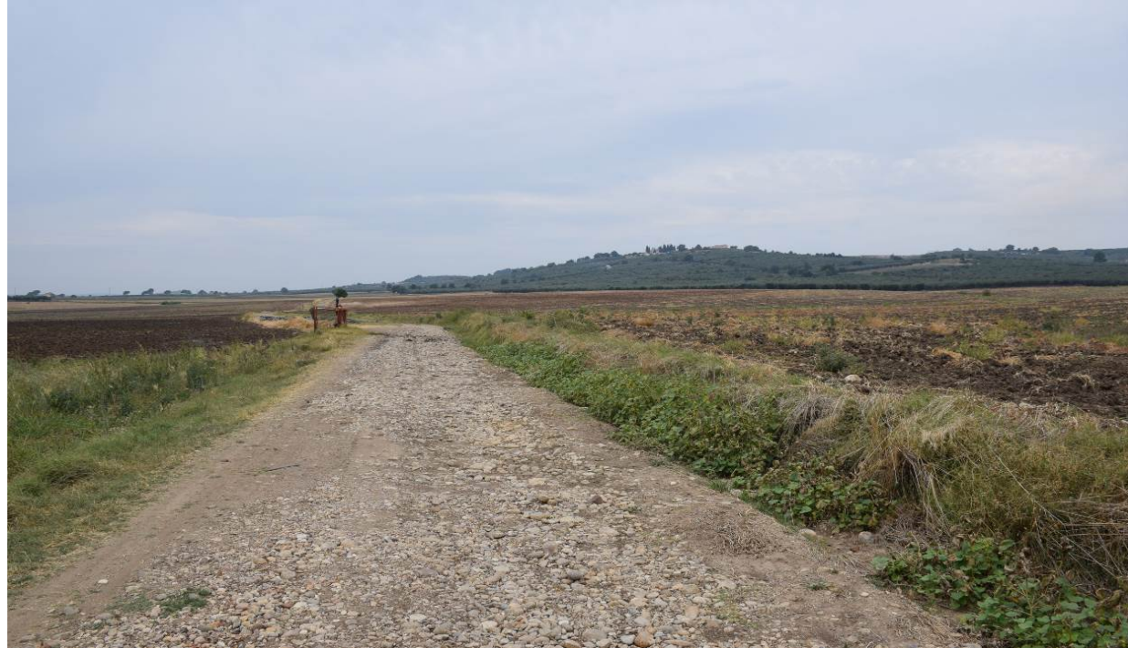
Figura 15 – Strada comunale “Maddalena-Ischia”. Come si scorge dalla fotografia, è evidente la necessità di adeguamento della viabilità esistente.
