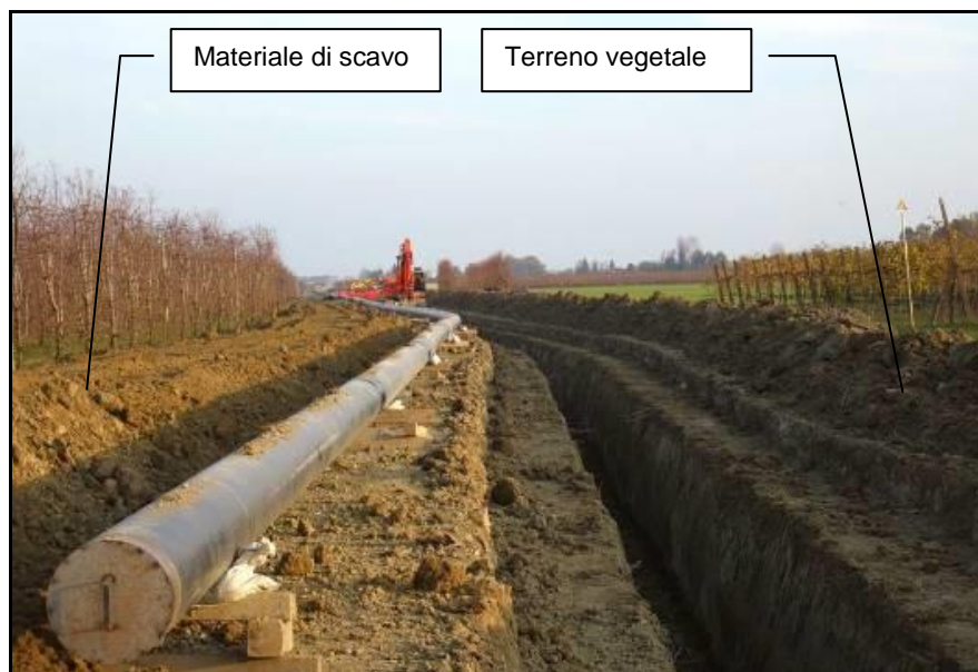
Fig. 4.4/C: Scavo della trincea
