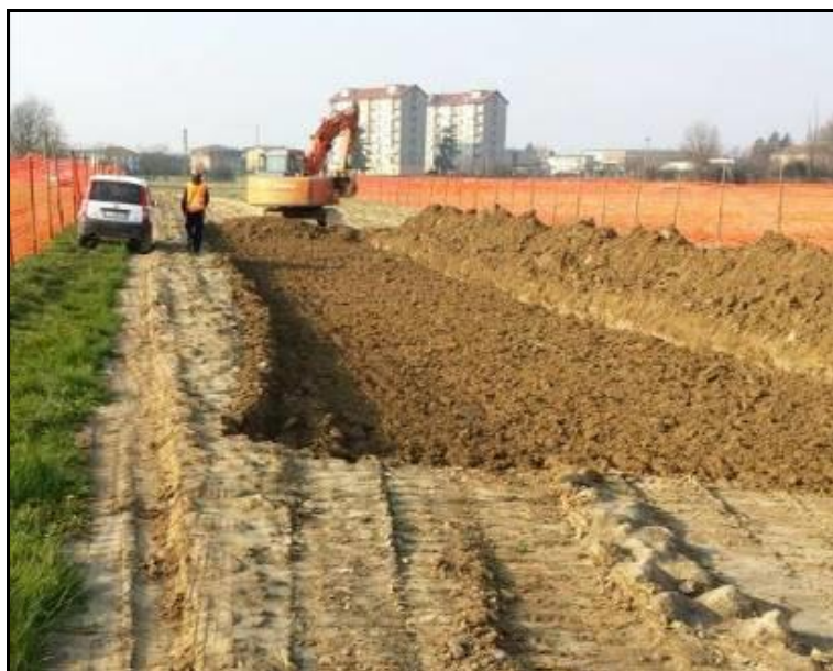
Fig. 4.4/B: Apertura della pista di lavoro
