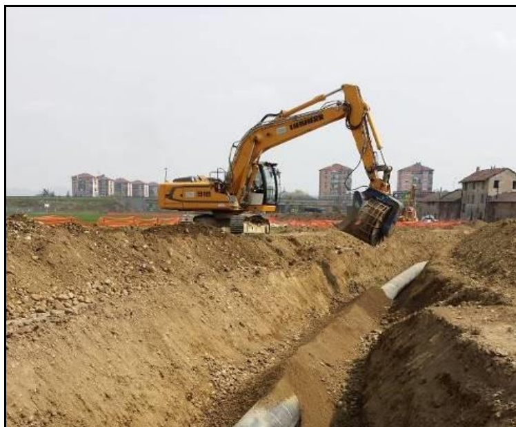
Fig. 4.4/D: Rinterro della condotta
