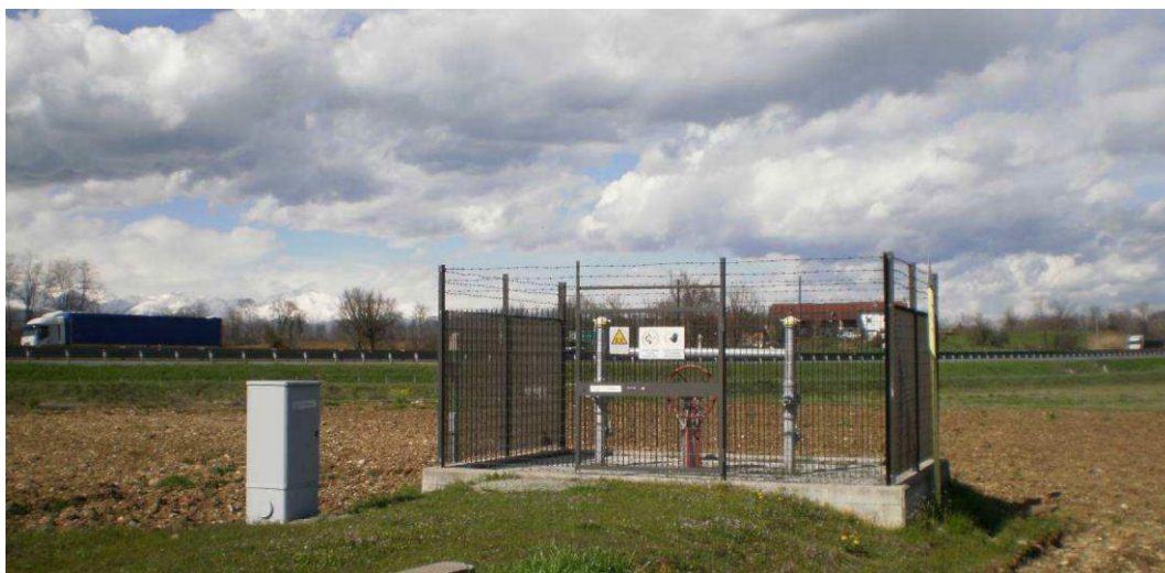
Fig. 4.4/H – Punto di Intercettazione di Linea (PIL)
