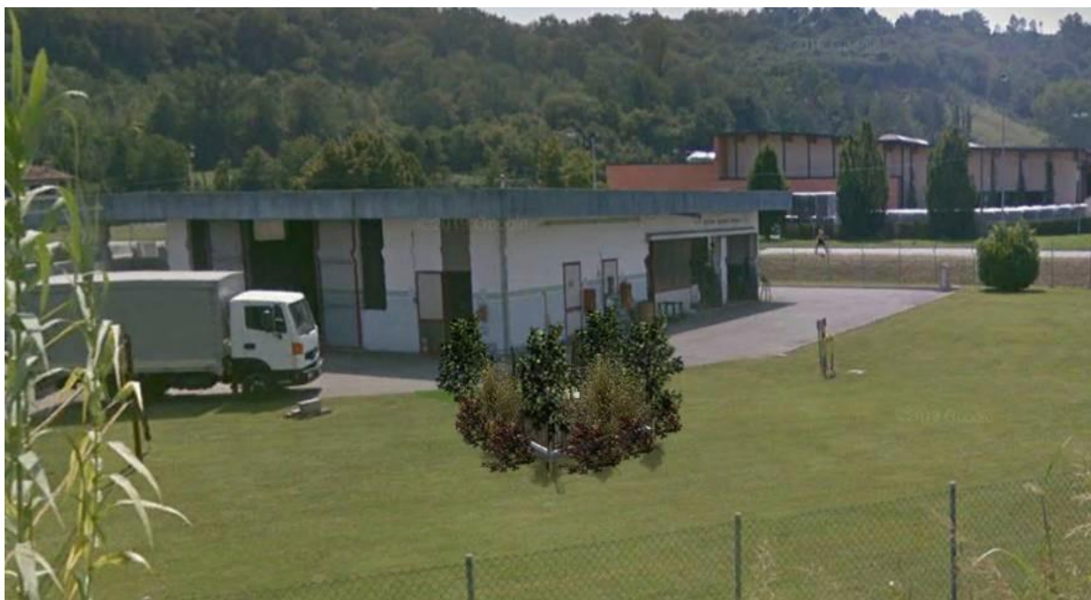
Foto 10 – Es. Mascheramento impianto
