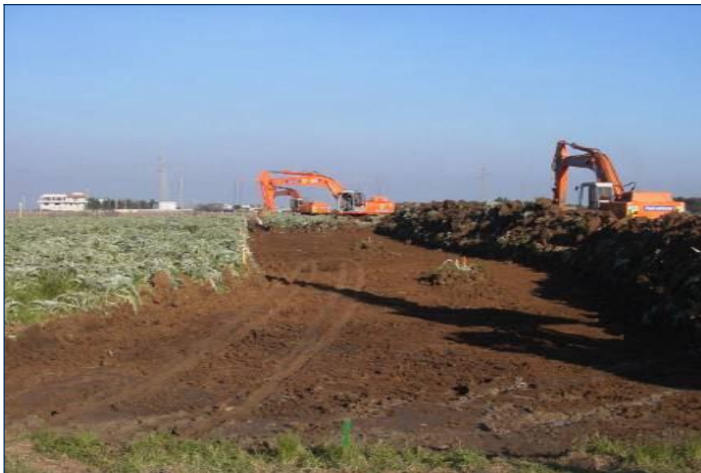
Foto 5 – Apertura area di passaggio scotico ed accantonamento terreno vegetale “humus”
