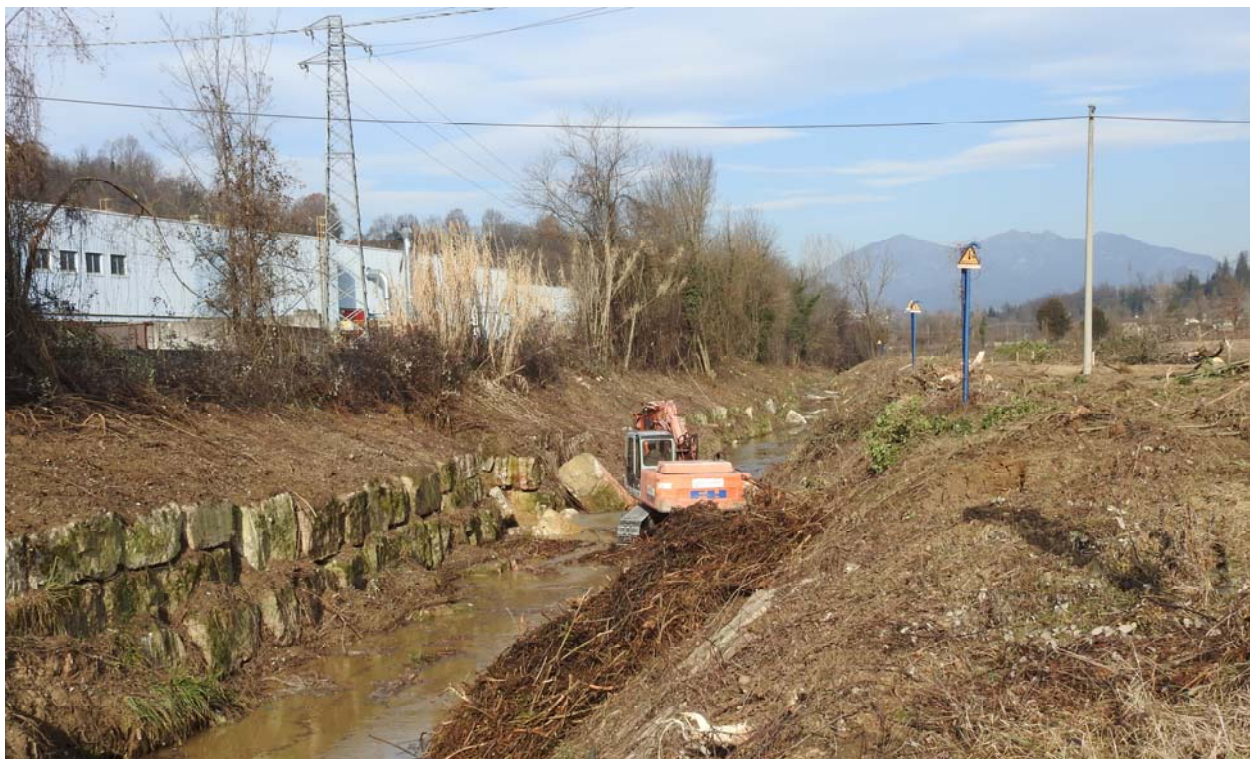
Fig. 33 – Torrente Crevada: intervento di sistemazione spondale con rimozione della vegetazione
