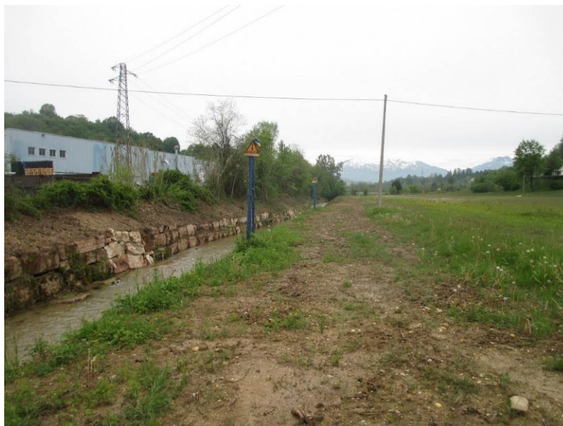
Foto 4 –Torrente artificializzato presso l'area VEP03SP VED01SP
