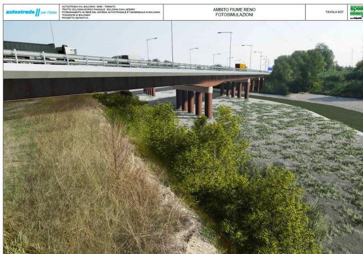
Le pile sono state inclinate secondo il flusso della corrente e allineate fra loro nelle pile più centrali. Solo le due pile dell'asse sud verso la spalla est (da una parte e l'altra dell'argine) sono inclinate diversamente per diminuire l'inclinazione reciproca tra pila ed asse tracciato.
