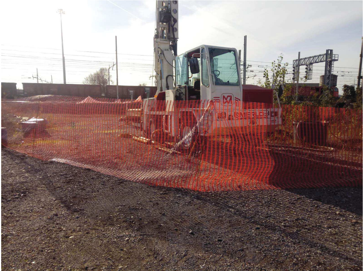
Figura 2 – Sonda approntata nel sondaggio S1
