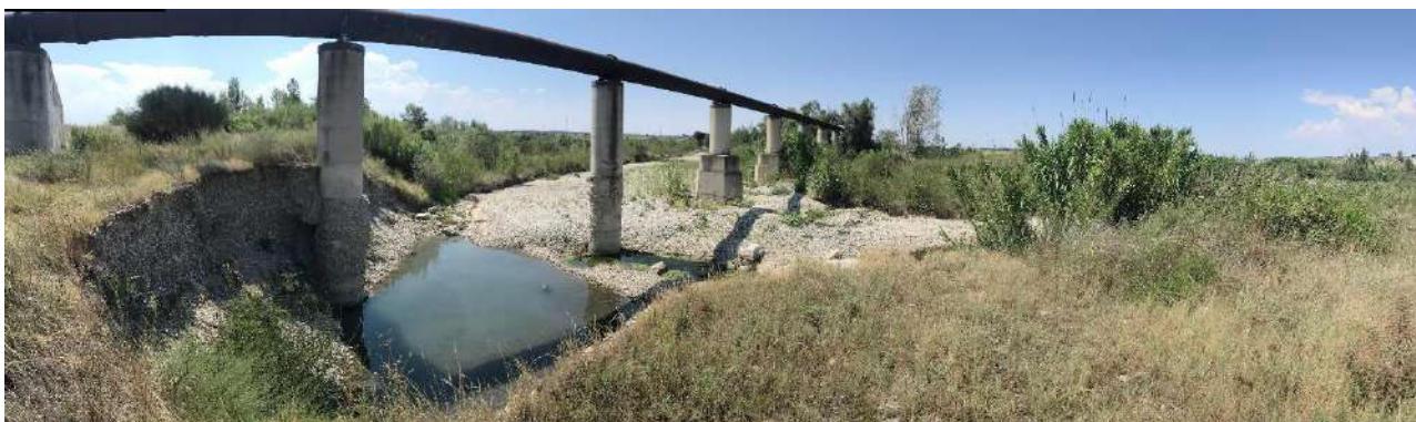
Figura 4.24 – Alveo Torrente Cervaro in corrispondenza dell'attraversamento con tecnica NO-DIG
