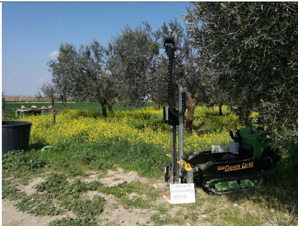
Ubicazione del penetmetro
