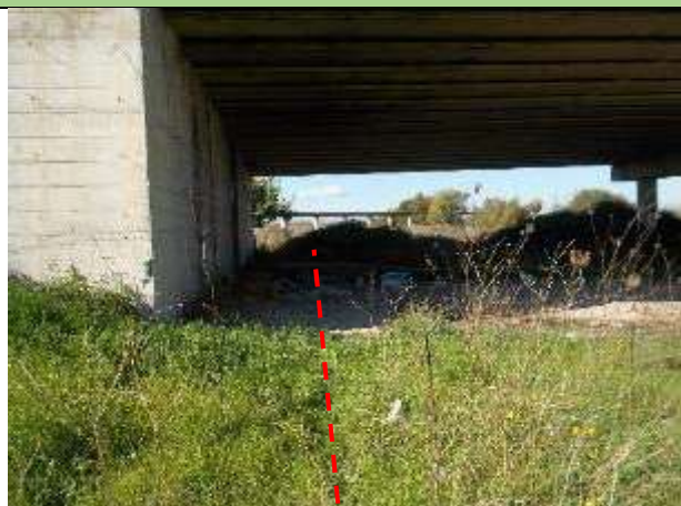
Punto di vista dal geofono G1
