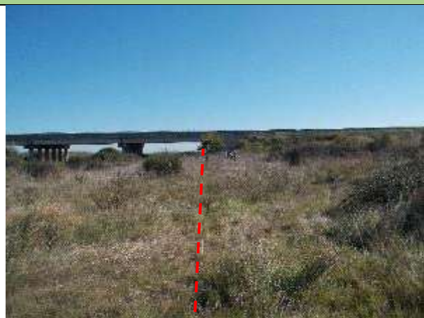
Punto di vista dal geofono G24
