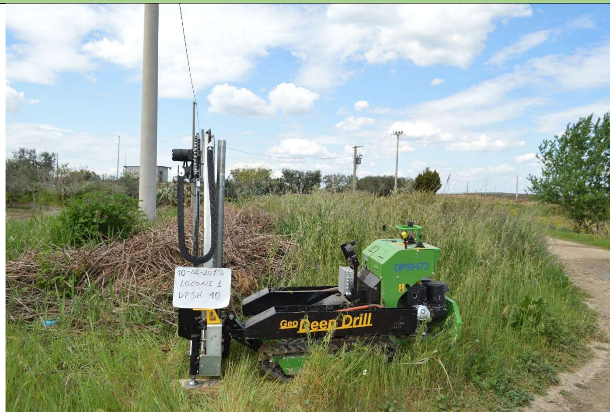
Ubicazione del penetrometro
