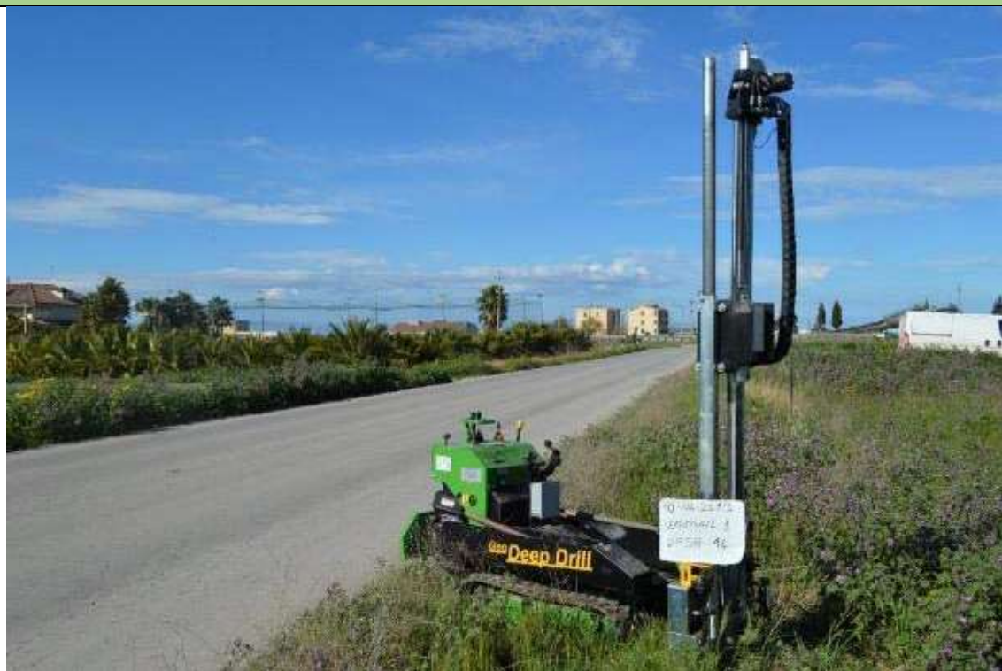
Ubicazione del penetrometro
