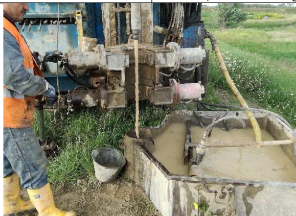
Prova di permeabilità
