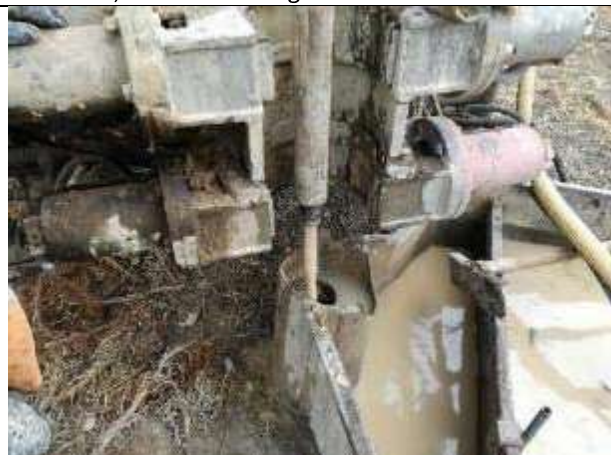
Prova di permeabilità
