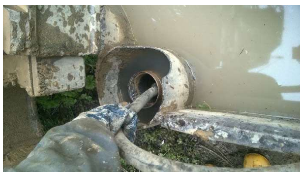
Prova di permeabilità
