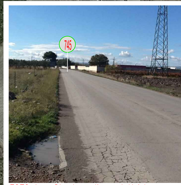
FOTO 1 - Strada - linee elettriche
