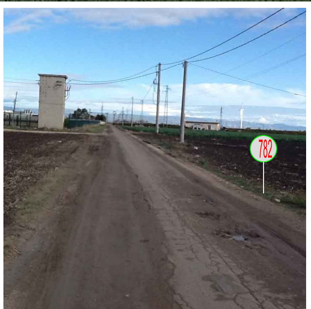
FOTO 1 - Strada - linee elettriche
