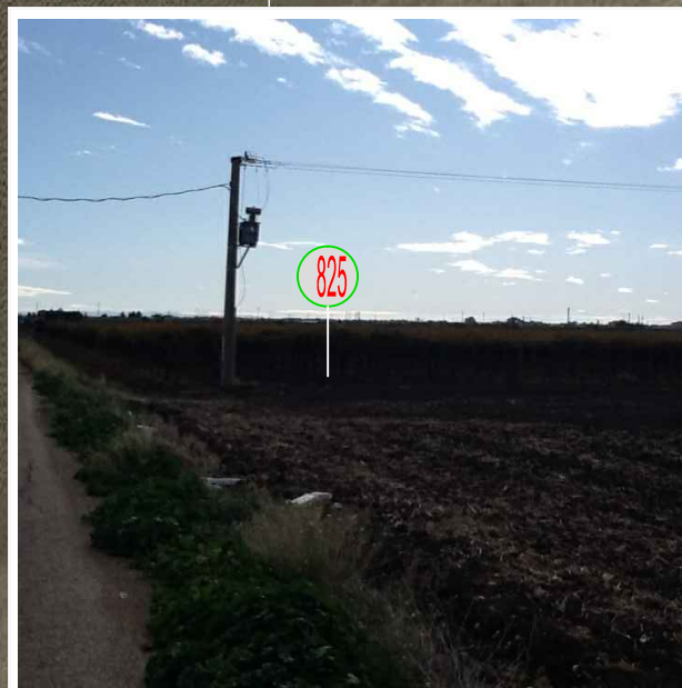
FOTO 1 - Strada - linee elettriche
