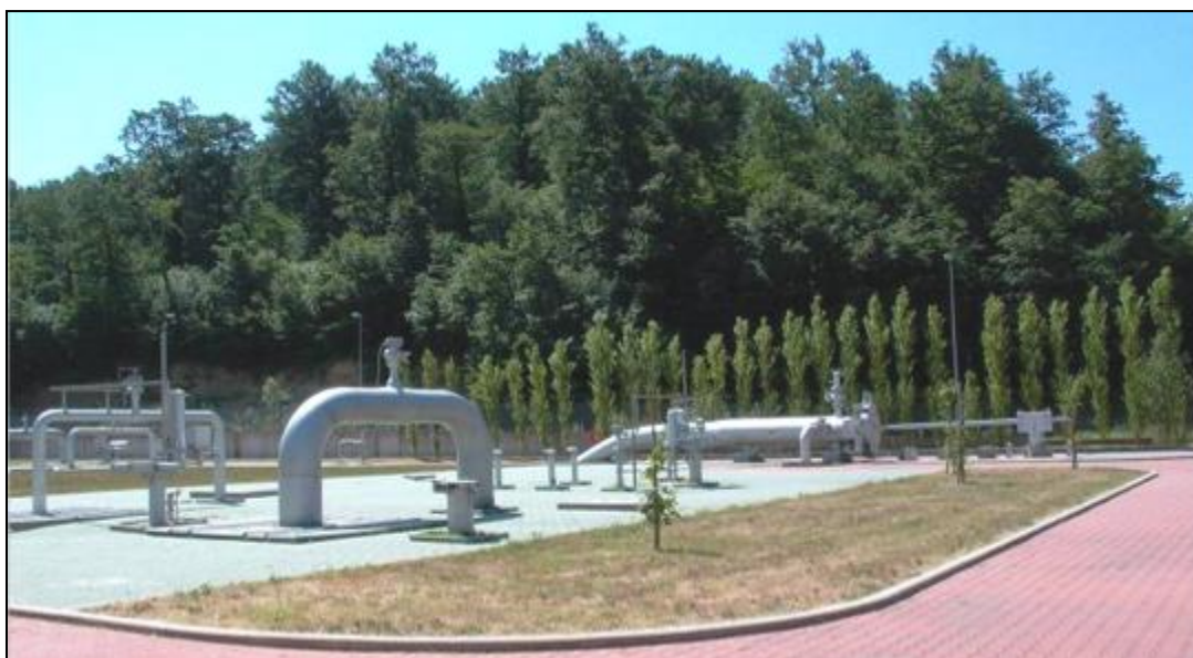
Fig. 9.10/B: Installazione tipo stazione di lancio e ricevimento PIG
