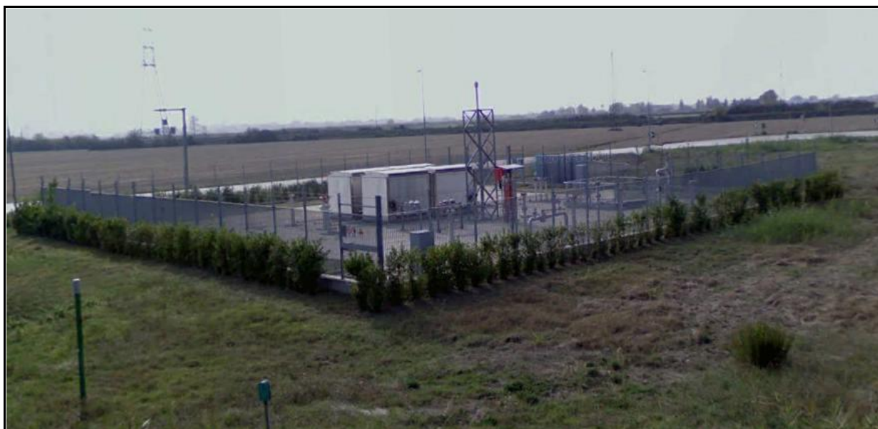
Foto n.14.2/A – Impianto con recente piantumazione di fascia di mascheramento.
