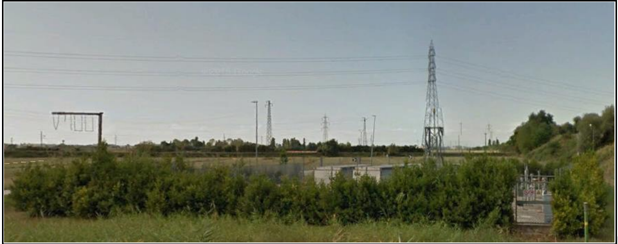
Fig. 8/B – Stesso impianto con fascia arbustiva di mascheramento ormai attecchita.
