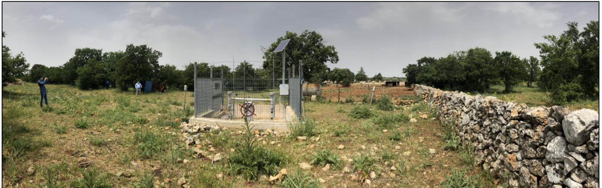
Fig. 8/E – Intervento n.3 - Stato attuale
