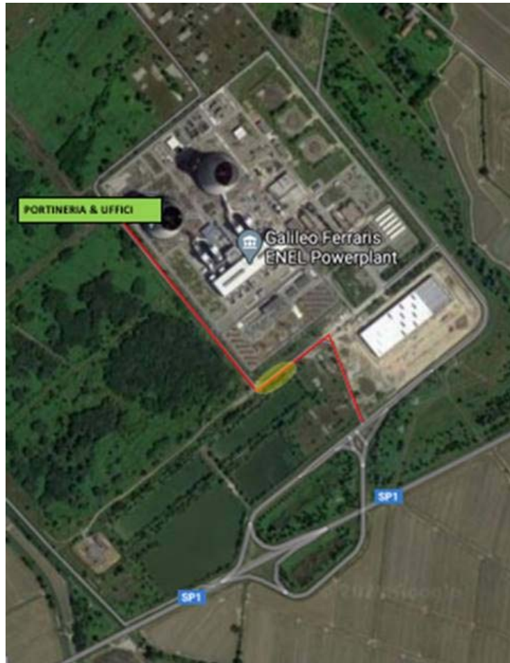
Viabilità di accesso al futuro impianto
