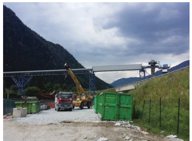
Baustelle Mauis 2 -Cantiere di Mules 2
