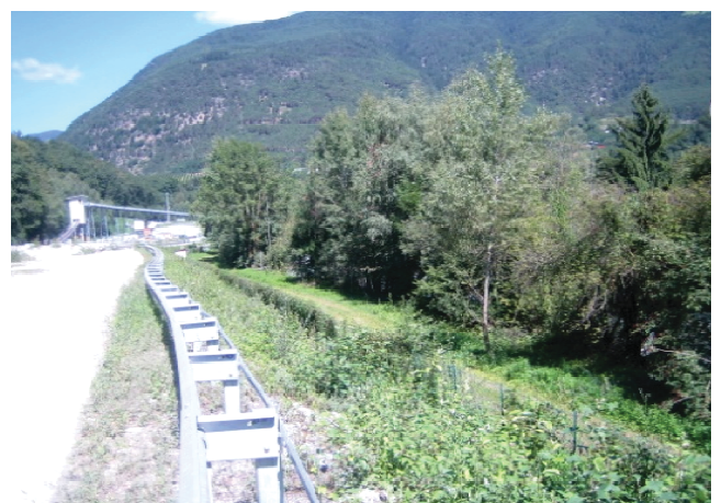
Uferzone Fascia ripariale
