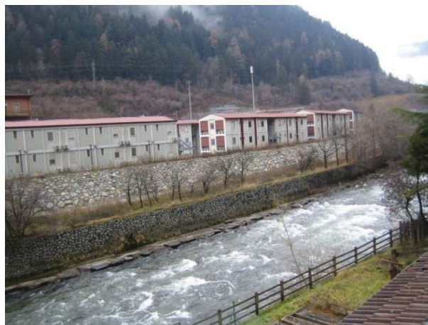
Ansicht der Baustelle Vista area di cantiere
