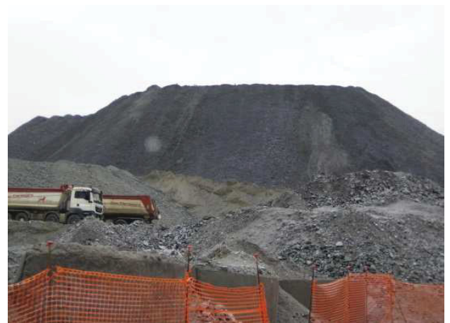
Erosionen an den südlichen Böschungen Processi erosivi sulle scarpate meridionali
