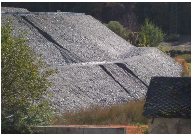
Erosionen an den südlichen Böschungen Processi erosivi sulle scarpate meridionali
