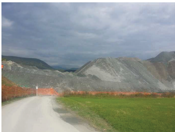
Materiale di scavo della galleria di Mules
