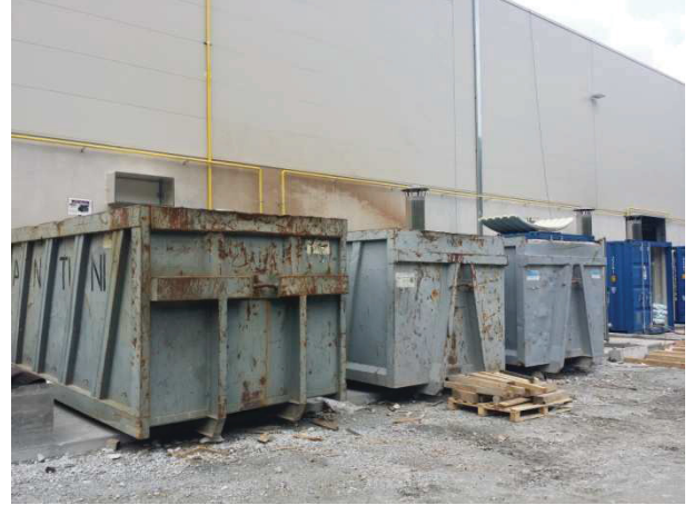
Baustelle Hinterrigger / Cantieri di Hinterrigger
