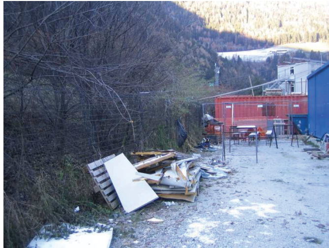
Baustellenabgrenzung Rete di confine
