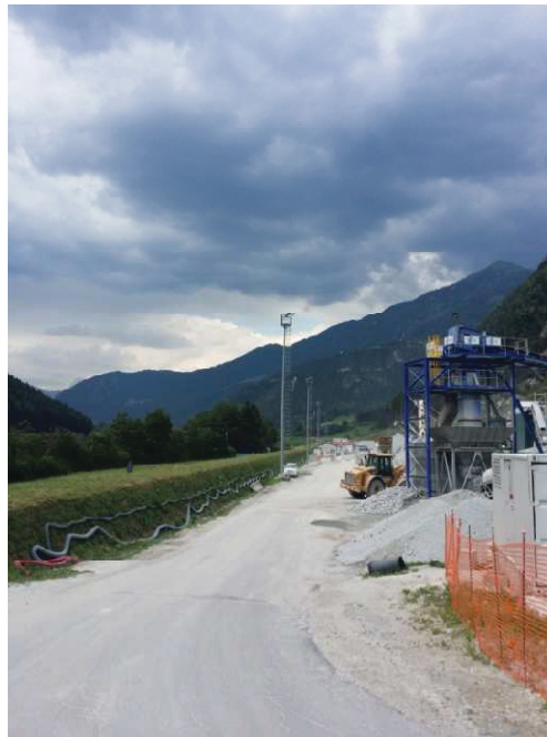
Baustelle Mauls 1 - Cantiere Mules 1
