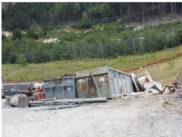
Baustelle Mauis1 -Cantiere di Mules1
