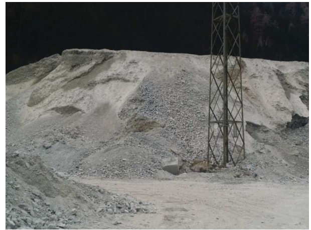
Cumuli di materiale di scavo della galleria di Mules
