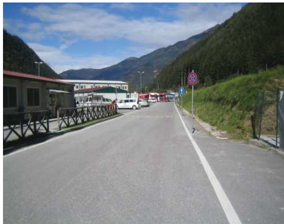
Ansich Baustelle Cantiere Mules 3
