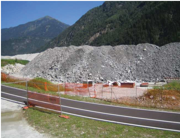
Abgrenzung von Baustellenbereichen Delimitazioni aree di cantiere
