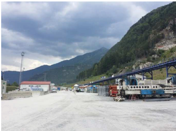
Baustelle Mault 1 - cantiere Mules 1
