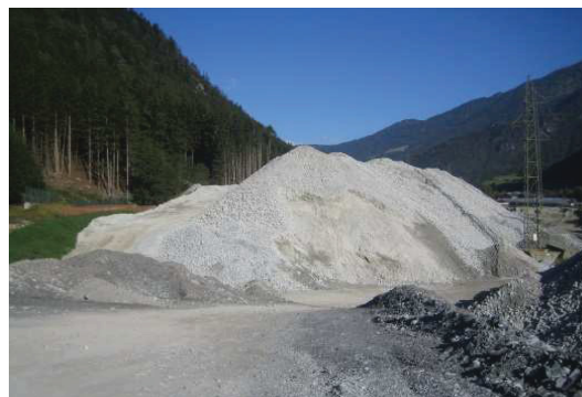
Cumuli materiale di scavo della galleria di Mules
