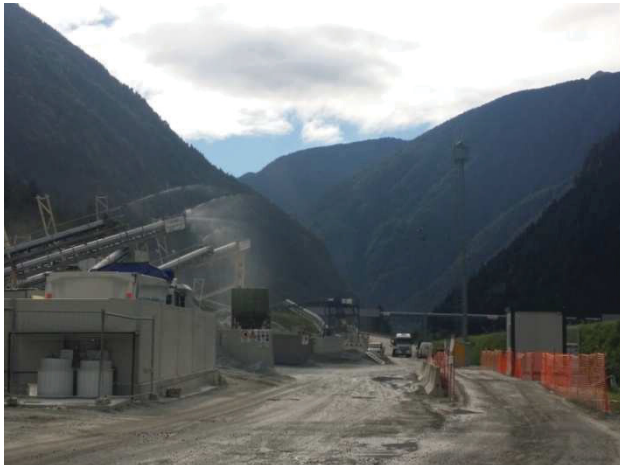
Sistema di umidificazione dei cumuli presso l'impianto di smistamento inerti
