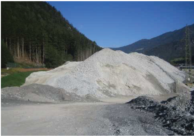
Cumuli di materiale di scavo della galleria di Mules
