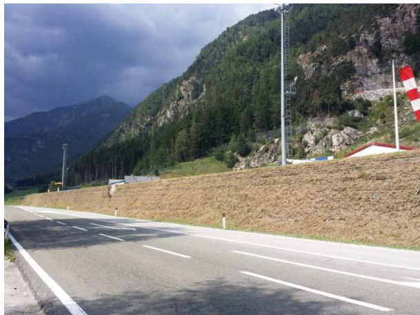
Baustelle Mauts 1 Cantiere Mules 1
