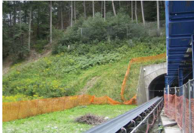
Portal Unterplattner, Tunnel Aicha - Hinterrigger Portale Unterplattner del cunicolo Aica-Hinterrigger
