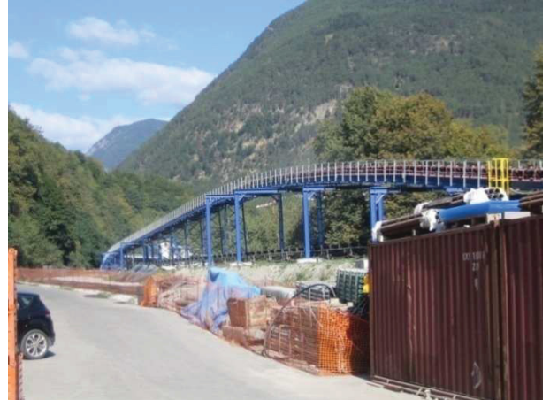
Teilansicht der Baustelle - Scorcio di cantiere
