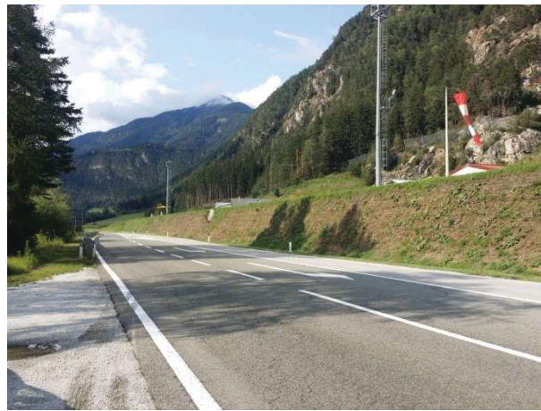
Vista del cantiere dalla strada statale
