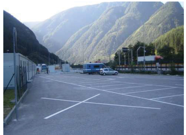
Baustelle Mault 3 - Cantiere Mules 3
