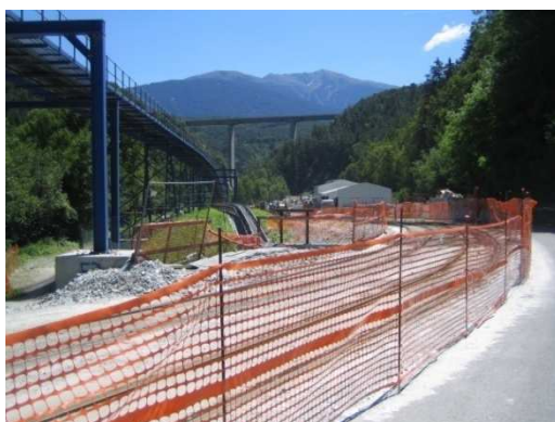
Ansicht der Baustelle / Vista area di cantiere
