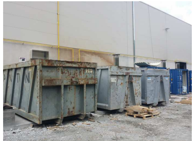
Baustelle Hinterrigger / Cantiere di Hinterrigger
