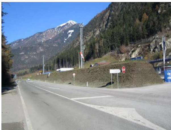
Vista del cantiere dalla strada statale
