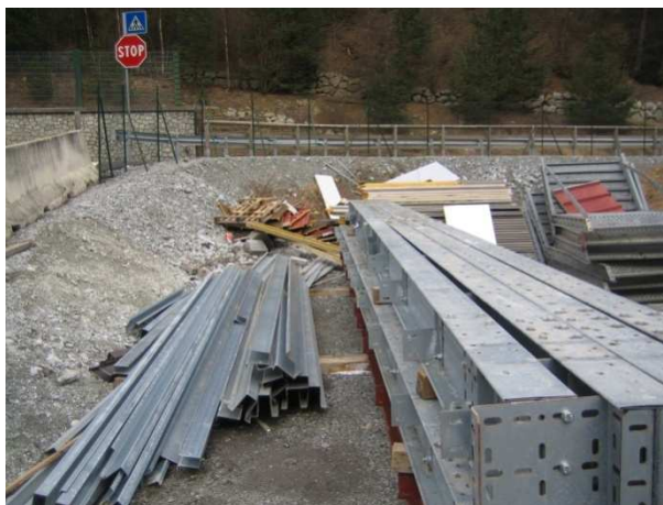
Baustellenabgrenzung Rete di confine
