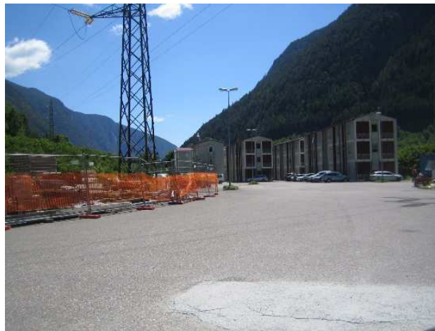
Ansicht der Baustelle Vista area di cantiere
