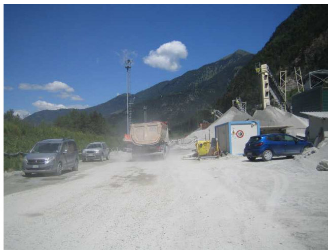
Anlage für Zuschlagstoffe Impianto inerti
