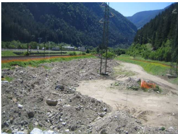
Aushubmaterial im Sektor Ost / Prodotti di scavo nel settore est
