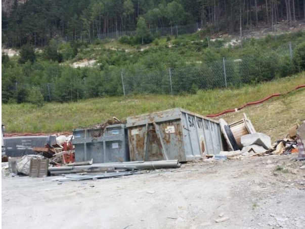
Baustelle Muls1 -Cantiere di Muls1
