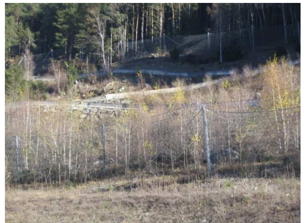
Reti paramassi sul versante che sovrasta il cantiere
