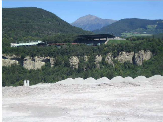
Ansicht der Baustelle
