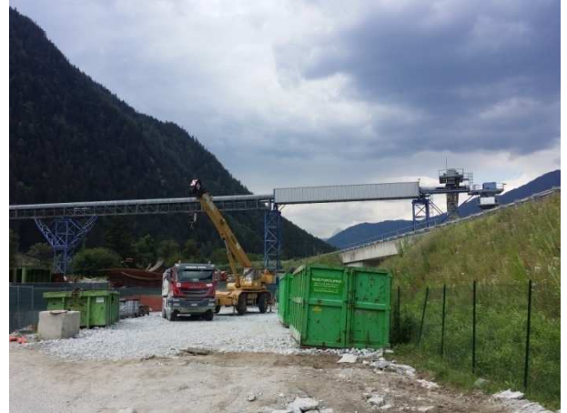
Baustelle Muls 2 -Cantiere di Muls 2
