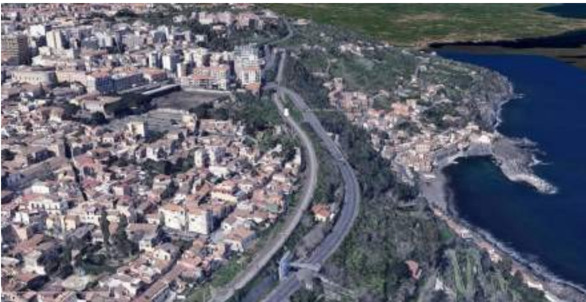
Figura 1 – Area d'intervento vista dal mare
